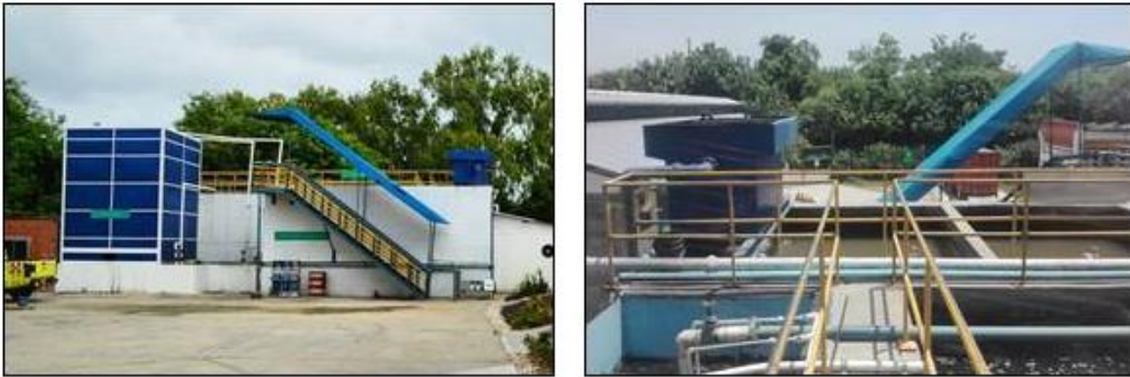
Figura 5. Vista general planta de tratamiento de aguas residuales - PTAR. Fuente: Propia.
