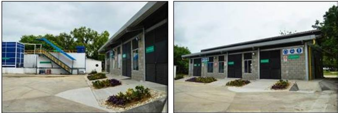
Figura 4. Vista general nuevo centro de acopio de residuos sólidos. Fuente: Propia.
